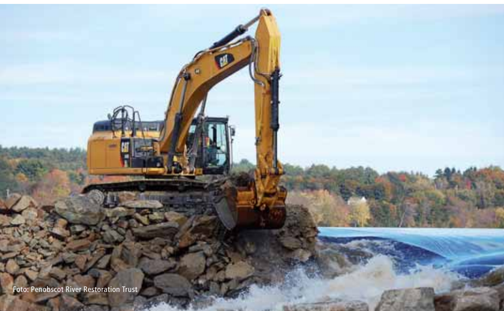
▼ Abb. 5: Rückbau des Veazie Damms am Penobscot River (USA) im Jahr 2013
